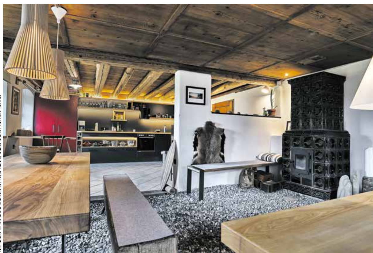
Mesner-Haus in Urspring. Küche und Esszimmer mit Lechiesel auf Lehmbohlen
